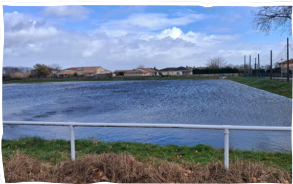
Bassin de rétention avenue de la Gare prévention des inondations aux Boulbènes
